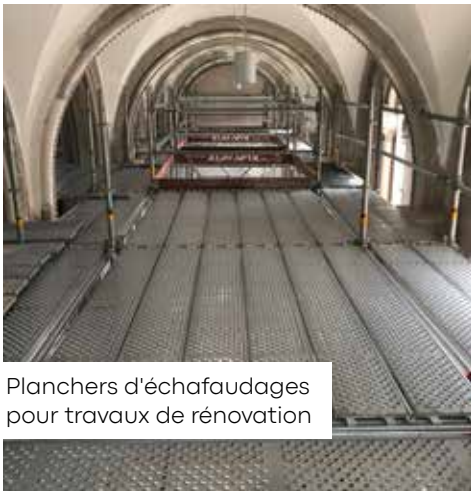
Planchers d'échafaudages avec charge jusqu'à 600 kg/m 2
