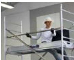
Grâce au système de fixation Décllic, les diagonales et les lisses du Docker2 se verrouillent automatiquement.
