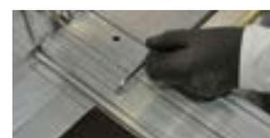
✓ Fixation des 2 planchers par crochets imperdables.
