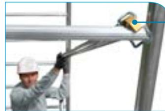
Pour le démontage, on libère le crochet le plus proche, puis en un tour de mains, sans se déplacer, on déverrouille l'autre extrémité.
