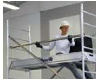
Grâce au système de fixation Décllic mis au point par Duarib, les diagonales et les lisses du DOCKER2 se verrouillent automatiquement.
