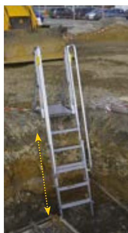
Piètements télescopiques réglables sur 4 hauteurs.
